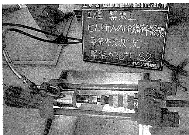
写真-4 NAPP 工法緊張力導入風景
