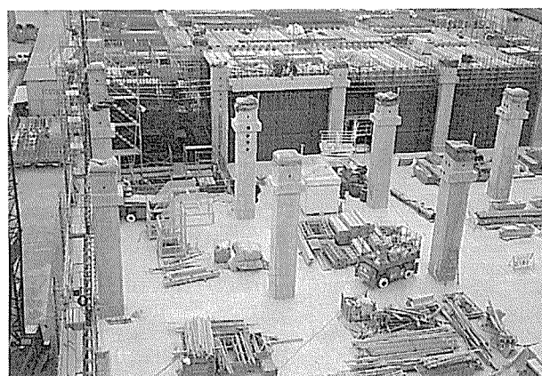
写真-2 自立柱設置状況
