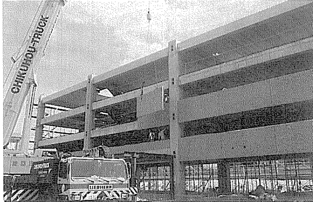
写真-5 PCaカーテンウォール架設状況
