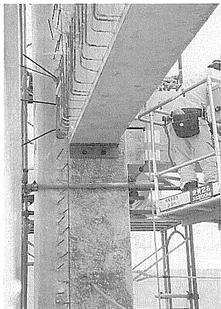
写真-2 耐震壁ジョイント部
