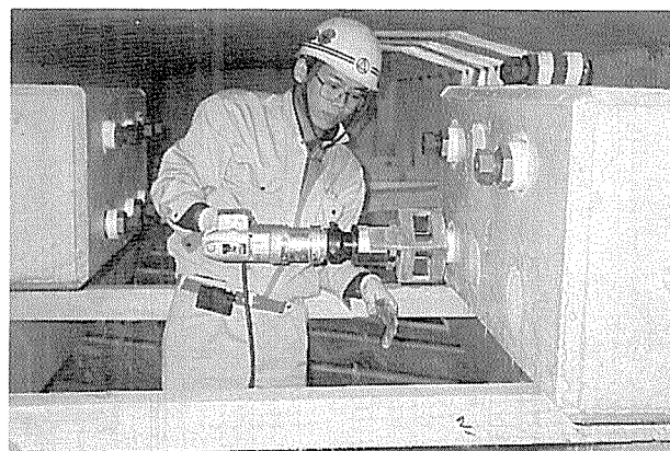
写真-7 中空鋼棒 プレストレス導入
