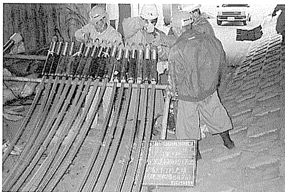
写真-8 アラミド緊張材定着部製作
