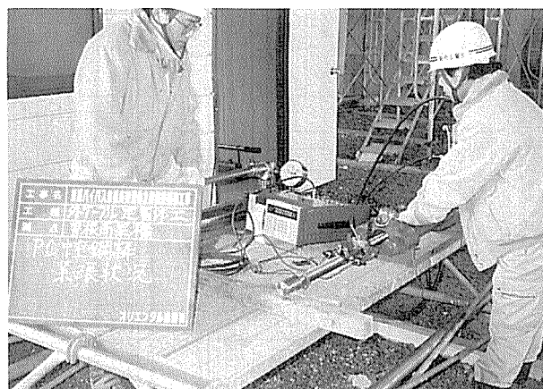
写真-5 中空鋼棒緊張
