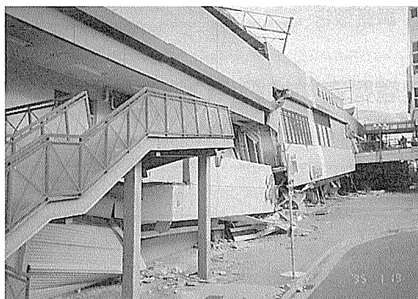
写真-12 東海道線 第3永手町高架橋
