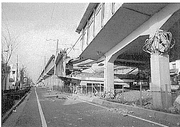
写真-1 山陽新幹線 第1野間高架橋
