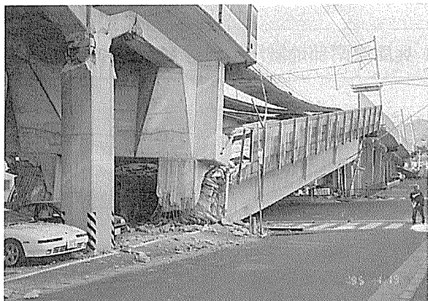
写真-11 東海道線 弓場架道橋
