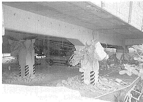
写真-9 東海道線 第2稗原町高架橋
