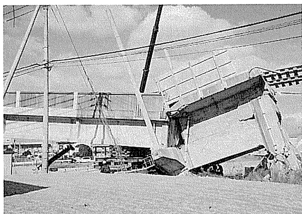
写真-6 山陽新幹線 伊川橋梁
