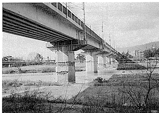
写真-7 山陽新幹線 武庫川橋梁
