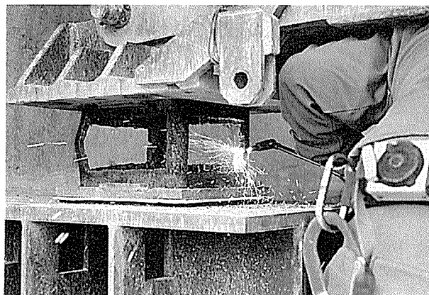
写真-6 切断支承の切断状況
