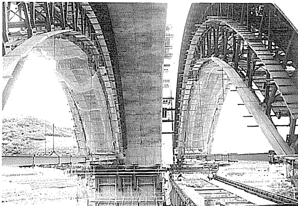
写真-7 アーチセントルの移動 (P 17 -P 18 から P 16 -P 17 への移動状況)
