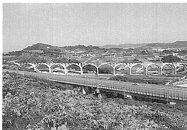
写真-1 南風原高架橋 手前に見えるのが沖縄自動車道
