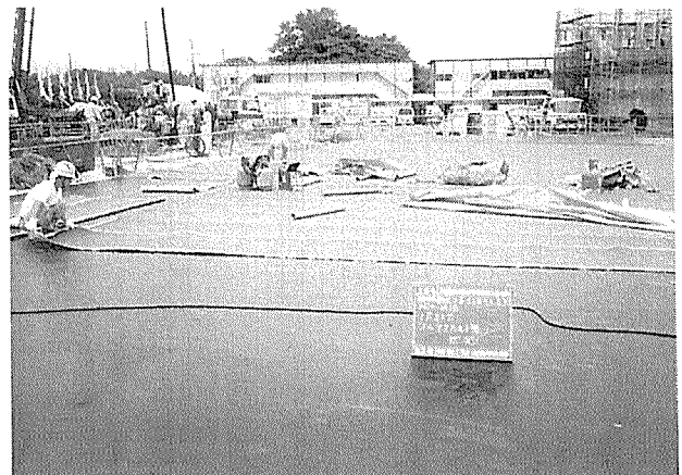
写真-11 スラブ面シート張り状況
