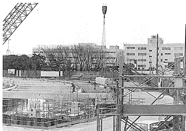
写真-3 大梁の架設
