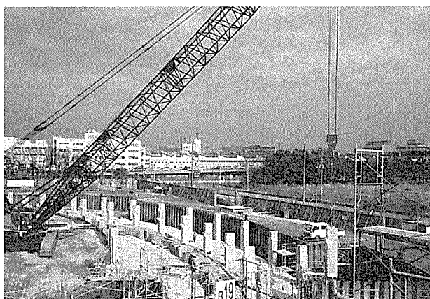
写真-2 柱の架設
