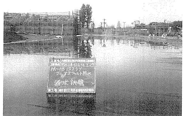
写真-12 漏水試験
