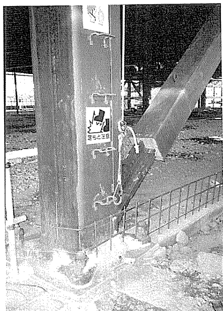
写真-3 アンボンドSRC ブレースを用いた架構
