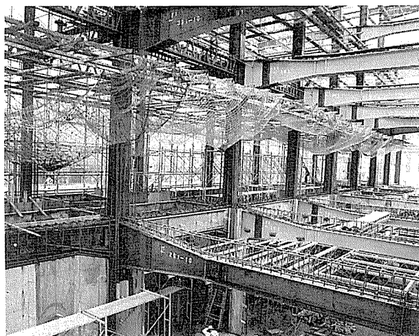
写真-4(a) リバースハンチ鉄骨建方
