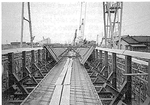
写真-7 波形鋼板ウェブの現場組立
