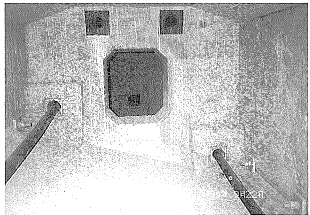
写真-5 外ケーブルの配置状況
