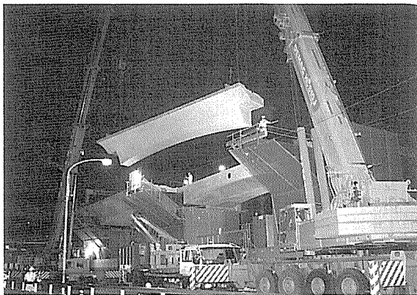
写真-4 U形桁の架設状況
