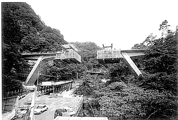
写真-4 張出し施工
