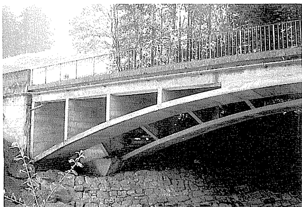
写真-10 スピタール橋(補剛アーチ)
