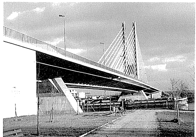
写真-12 第二メイン橋
