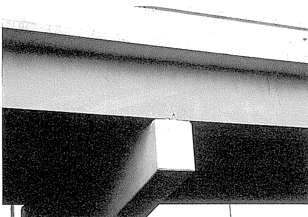
写真-7 Long Island Bridge 中間支点上
