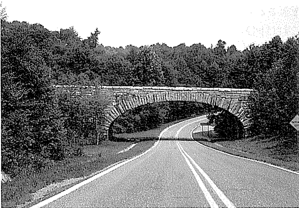
写真-3 ブルーリッジパークウェーのRCアーチ
