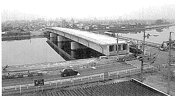
写真-1 完成写真
