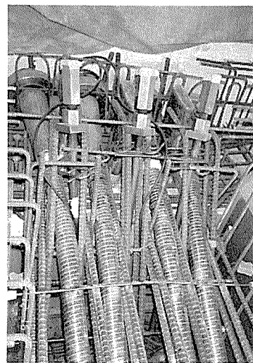
写真-4 支承部の配筋状況
