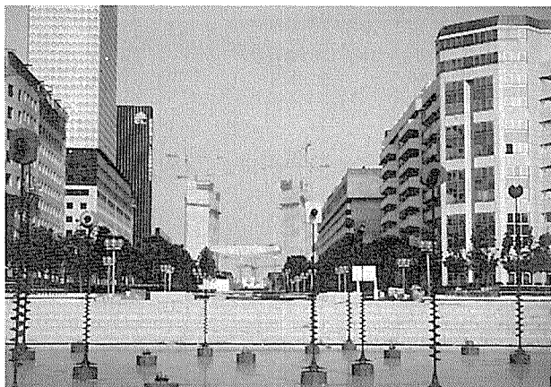
写真-20 工事中のグラン・アルシュ
