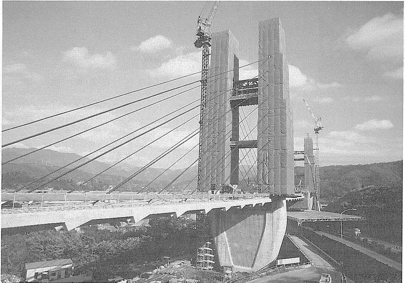
工法、ウェブ鉛直鋼棒にFAB工法、斜材定着位置の横桁にVSL工法が採用されているほか、床版には東名高速道路改築工事全体で統一して使用されているフレシネー工法が用いられている。見学当時の東名足柄橋の施工状況は、斜材についてはP<sub>1</sub>主塔側全10段(40本)の架設を終了、P<sub>2</sub>主塔側は8段の架設を終了して9段目を架設中であった。桁に関しては3径間の桁の中央閉合部2ブロックの施工と両端(A<sub>1</sub>側1ブロック、P<sub>3</sub>側2ブロック)の施工を残した状態で、年内閉合を目指して施工中であった。
