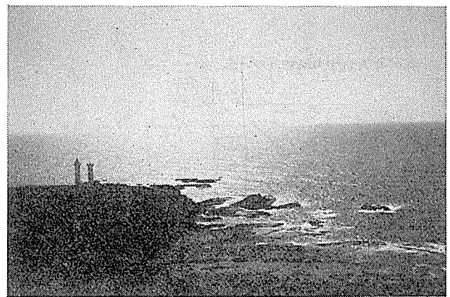
写真-1 架橋付近の情景
