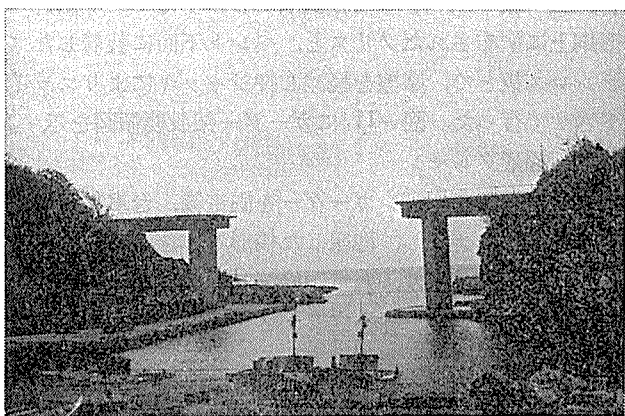
写真—4 側径間施工完了
