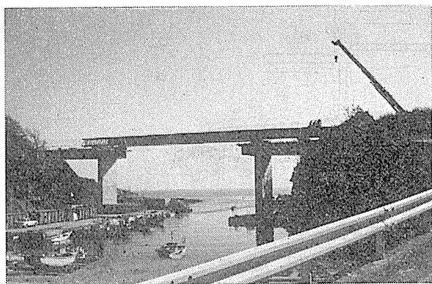
写真—7 エレクションガーダー架設完了
