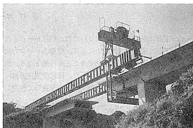
写真—10 接合目地の施工
