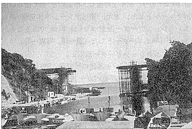
写真—3 側径間支保工全景
