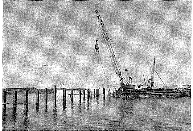
写真-2 仮設栈橋
