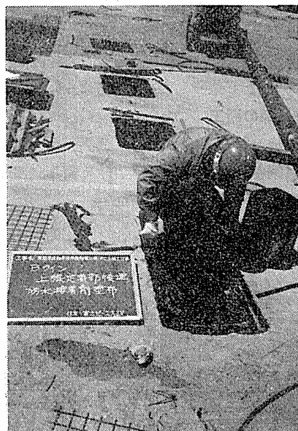
写真—7 上縁定着部後処理
