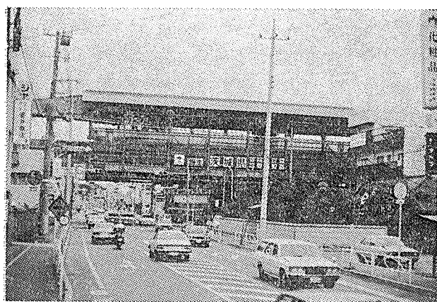
写真-6 大型移動吊支保工1号機の交差点部の通過
