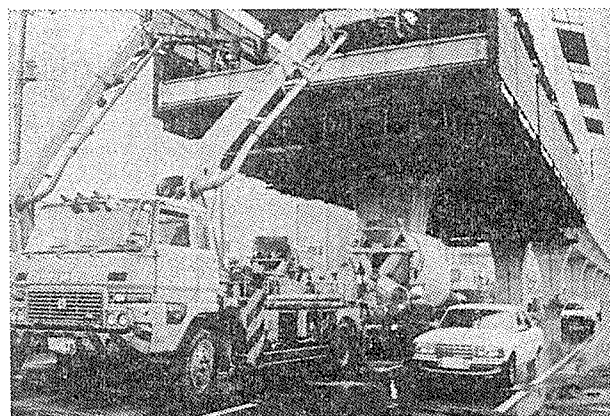
写真-12 大型移動吊支保工のコンクリート打設
