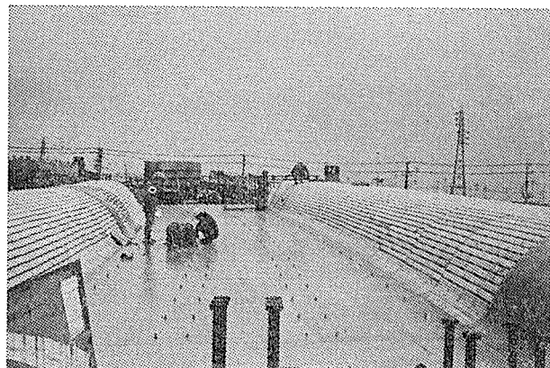
写真—4 PC曲線ホロー桁部型枠組立て
