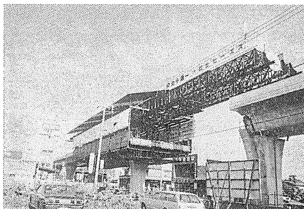
写真-8 大型移動吊支保工2号機
