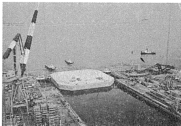
写真-6 BB-44 出渠状況
