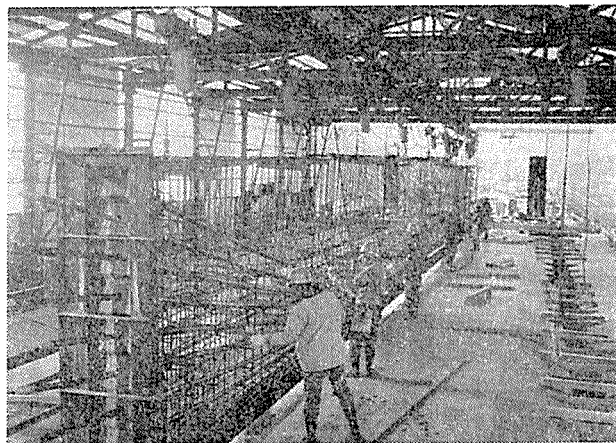
写真-6 主桁鉄筋, PC 鋼線の設置
