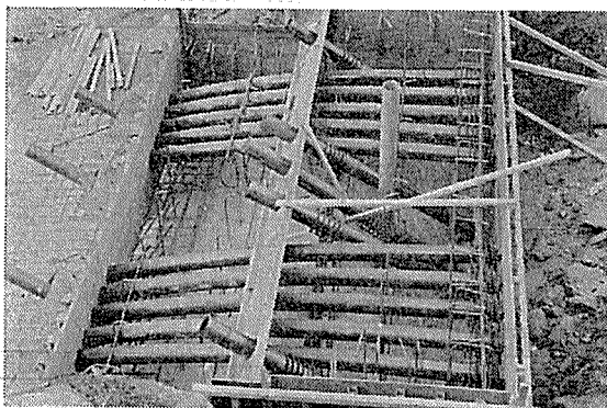
写真-5 アバット製作
