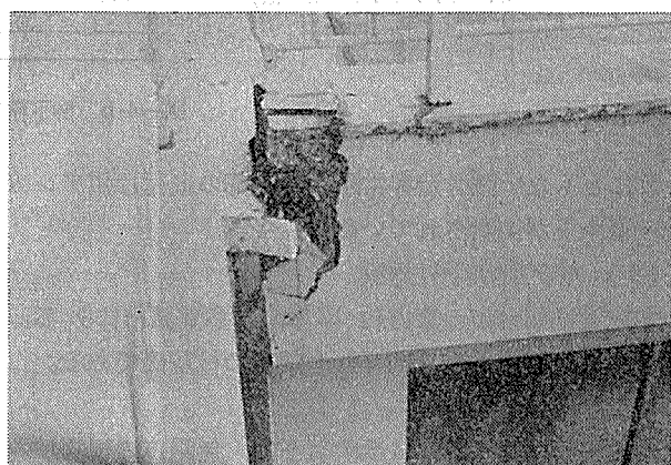
写真—3・c 柳下精工鉄骨階段取付け部
