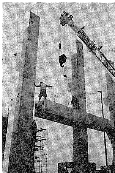
写真-5 PC 桁梁架設作業
