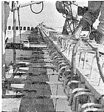
写真-6 高架橋の横締め
