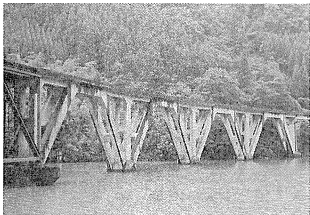
写真—13 第3五箇瀬川橋梁
