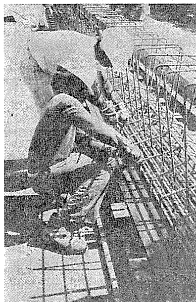
写真-5 鉄筋組立
