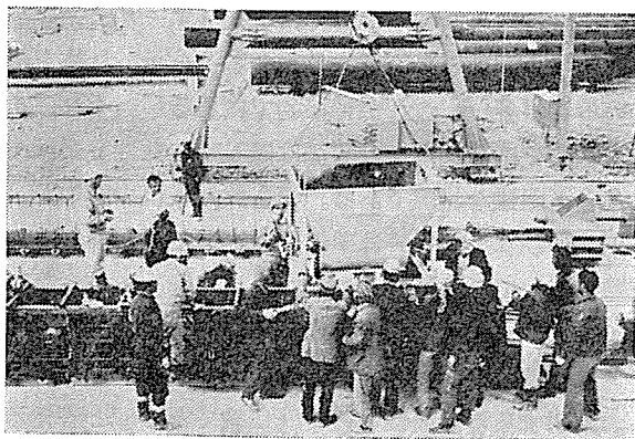
写真—7 コンクリート打設
