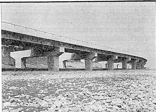
建設省 西湘バイパス道路
