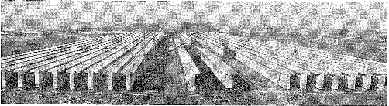
写真-1 主桁製作ストックヤード全景
