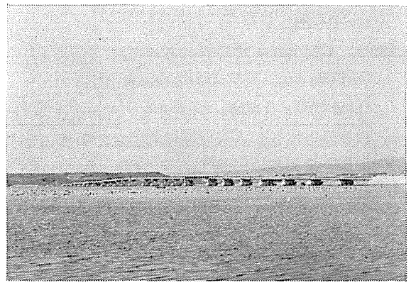
写真—12 桁架設完了全景
