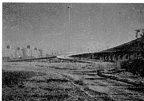
写真—2 照明ポール
