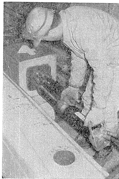
図—19 テンドンのつかみ長さをそろえるために CCL ジャッキで緊張している状態
