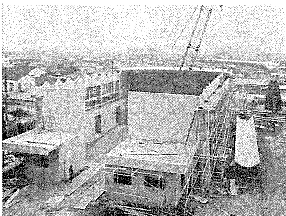
写真-5 架設中の S.C.S. 版
