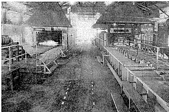
写真—1 パテンティング工場
