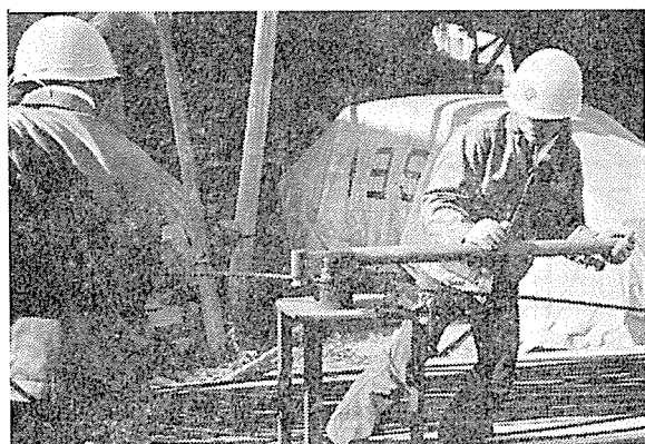
写真-3 加工用ローラー上でのケーブル組立て状況
