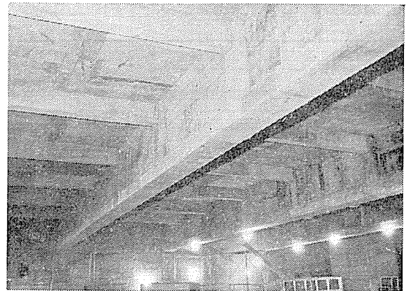
写真—9 プレストレス導入後の PC ばり
