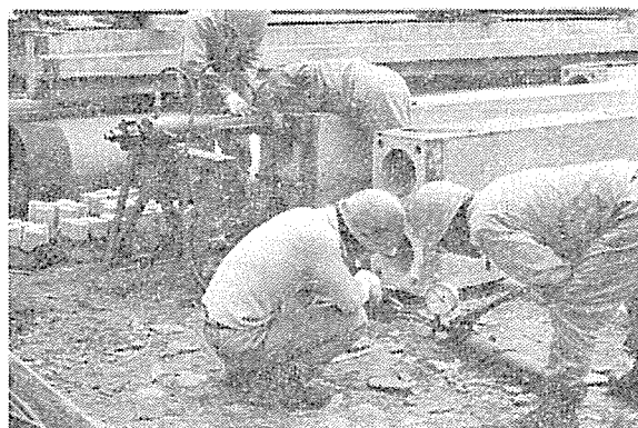
写真-2 緊張作業 (のちにグラウチング)
