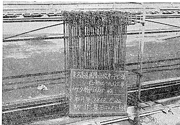
写真—2 鋼線引きそろえ
