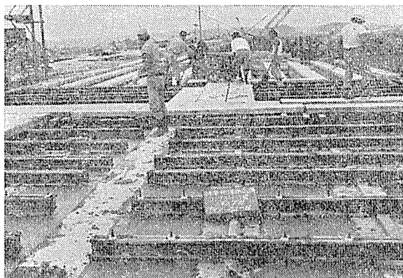
写真—11 間詰めコンクリート打設
