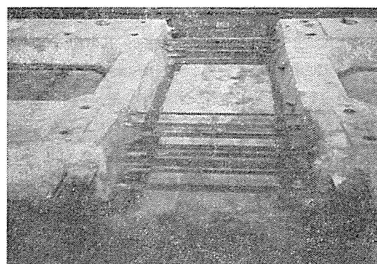
図-8 プレストレス導入直前のPCパネル
