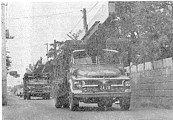
写真-1 キャスト全長 15 m の小ばりの運搬 (井の頭道路上)
