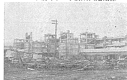
写真-9 リフトアップ完了後プレキャスト部材取付中 右上宿泊棟，右下渡廊下 手前飛出階段棟
