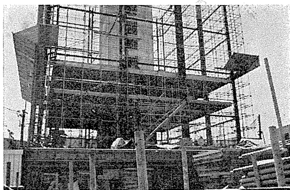
写真-12 二層つりリフトスラブ工法
