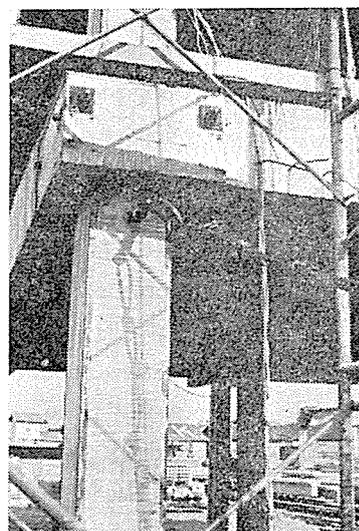
**Photo 6. Joint b, on distingue le martier à base de résine époxy, plus sombre que le mortier ordinaire**
