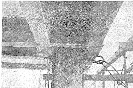
**Photo 8. Joint d. La partie centrale du collier est coulé puis rebouchée au mortier**
