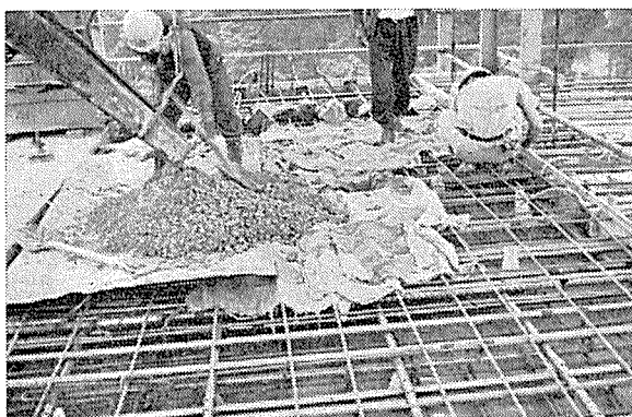
写真—4 底スラブ コンクリート打設中
