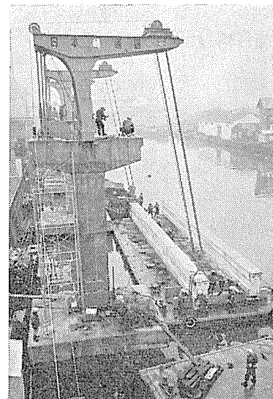
写真-5 T型デリック架設
