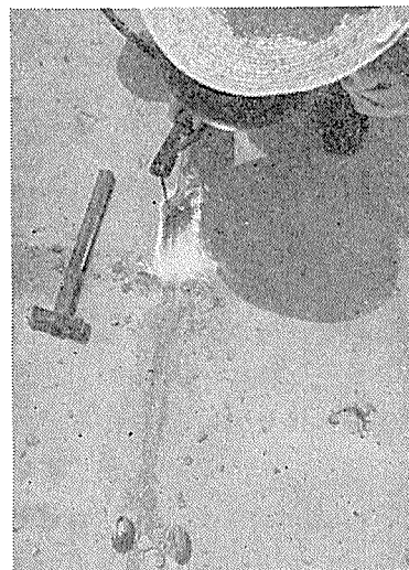
写真—11 ブロック目地鉄筋溶接
