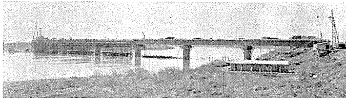
写真-1 工事中の矢作川橋梁
