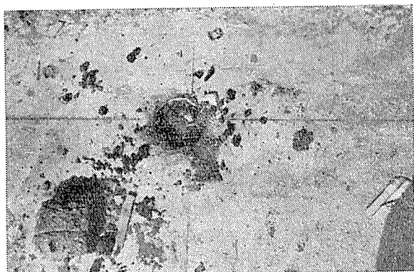
写真—8 桁行方向壁の PC 鋼棒アンカー
