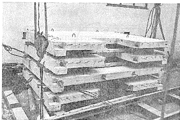
写真—6 張間壁板の型ワクおよび配筋
