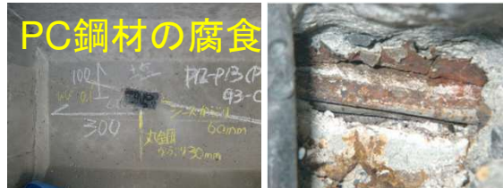
上縁定着の後埋め部から浸入した水による変状
