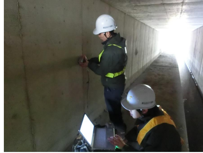
ボックスカルバート (撮影者: 内藤)
