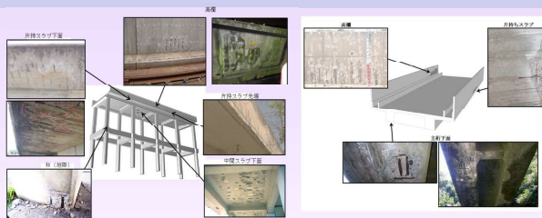
高架橋の着目箇所
